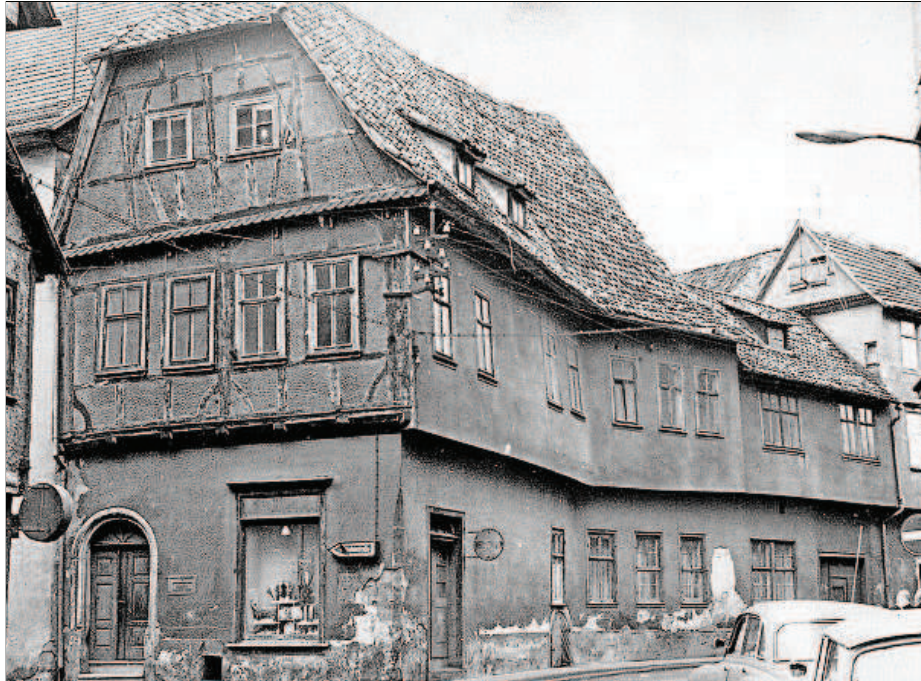
Lutherplatz 10 und 11. Lutherplatz 11 im Jahre 1974. Das Eckhaus zwischen Lutherplatz und Hoffnung ist 1976 abgerissen worden. Lutherplatz 10 blieb noch einige Jahre stehen und wurde erst kurz vor dem Neubau des Sanitätshauses Seeber (1992) abgerissen. Das Sanitätshaus steht dort jetzt anstelle der beiden Häuser.
